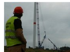
Stavba větrné elektrárny v obci Vítězná na Trutnovsku.
