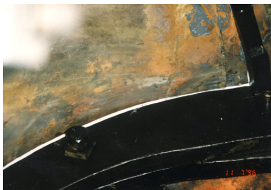
Obr. 13. Eliminace galvanického článku v atmosféře
