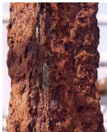
Obr. 26b. Objemné korozní produkty na hlavním nosníku kovových plastik Sloupu nejsvětější Trojice v Olomouci
