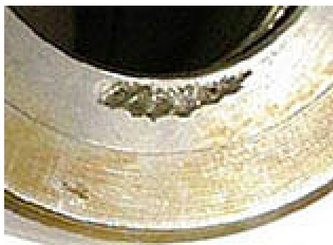
Obr. 14 Štěrbínová koroze korozivzdorné oceli pod těsněním
