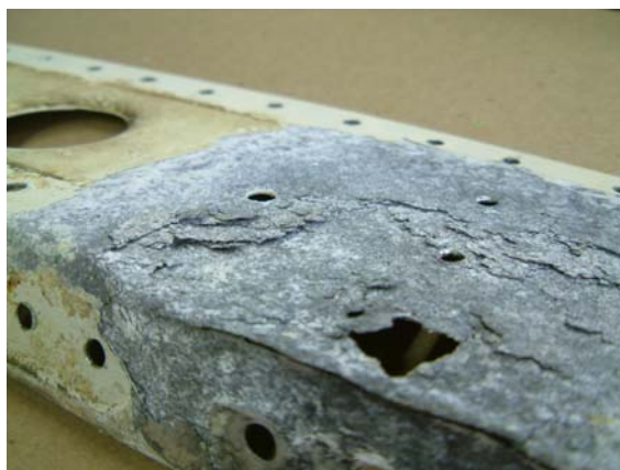
Obr. 17. Koroze po vrstvách hliníkové slitiny duralu
